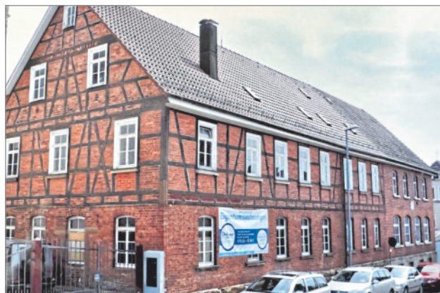
1872 erbaut - 2019 abgerissen. Ein attraktiver Neubau entstand, ein markantes Gebäude wurde abgerissen.
