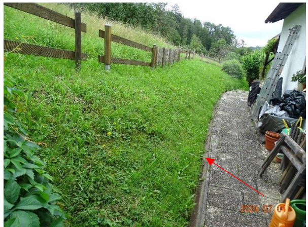
Abb. 8: Böschung hinter dem Einfamilienhaus mit da-runter liegendem Regenablauf (roter Pfeil)
