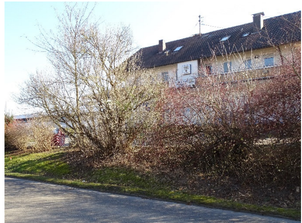
Abb. 8: Ziersträucher und -gehölze auf Nordseite des Gebäudes
