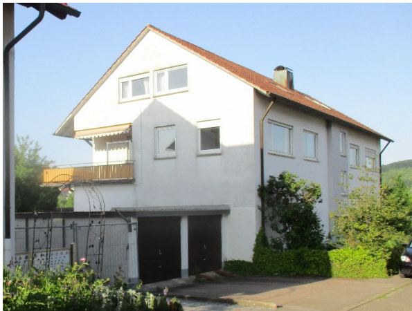
Abb. 3: Blick von Südwesten auf Gebäude mit Garagen
