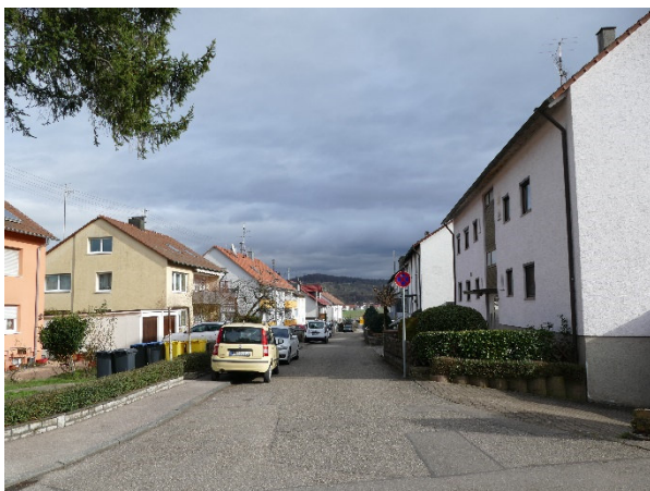
Abb. 9: Blick nach Osten auf Gebäude mit Vorgärten
