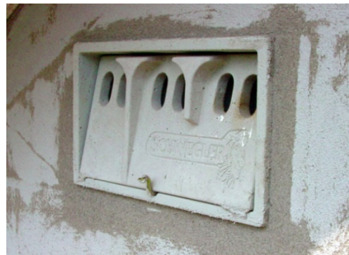
Abb. 12: Sperlingskoloniehaus 1SP in Fassade integriert 5
