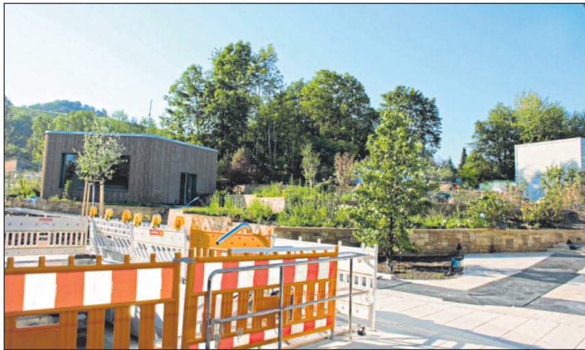
Laufende Arbeiten im neuen Saunabereich
