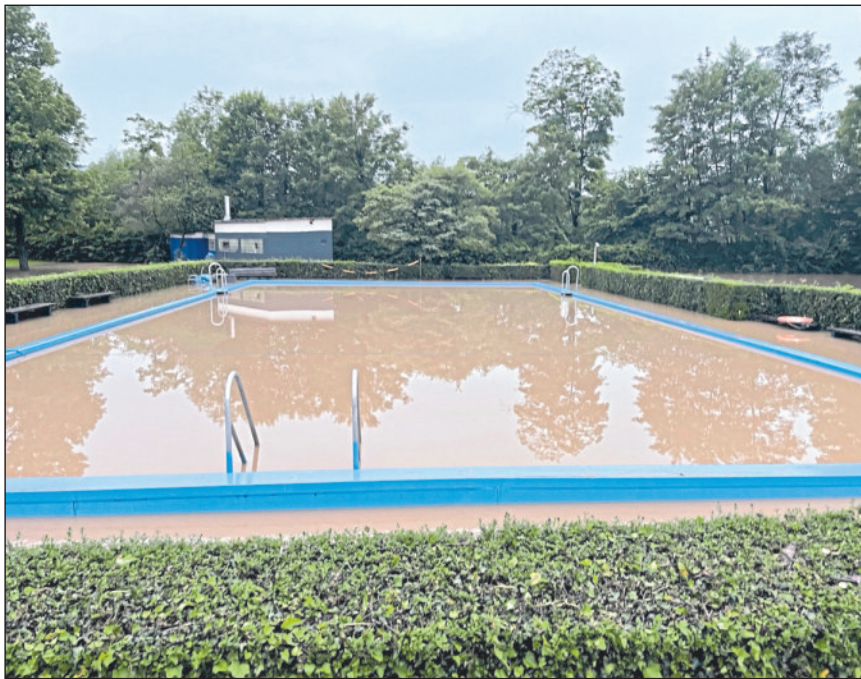
Das Mineralfreibad wurde durch das Hochwasser stark beschädigt. Foto: Stadtwerke Winnenden
