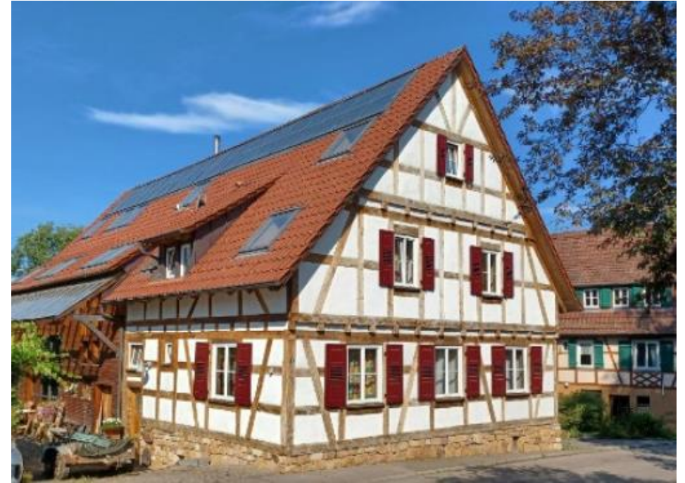
Beispielfoto einer erfolgreich abgeschlossenen Modernisierungsmaßnahme
