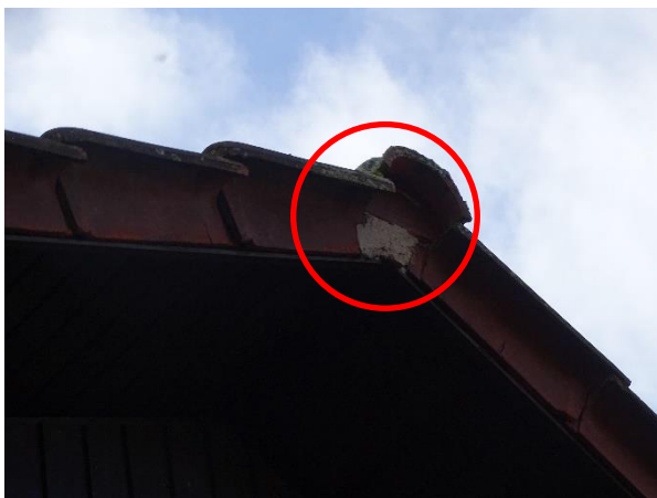
Abb. 17: Verschlüssener Ortgang (rote Markierung) an der Nordseite des Bestandsgebäudes
