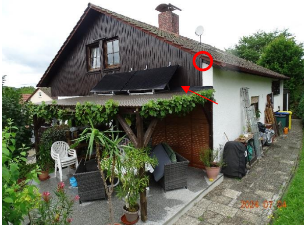
Abb. 15: Brutmöglichkeiten am Bestandshaus (Südseite, rote Markierungen)
