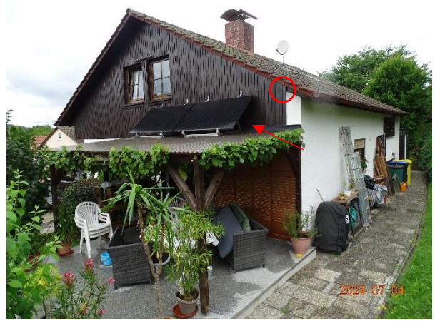
Abb. 10: Brutmöglichkeiten am Bestandshaus (Südseite, rote Markierungen)
