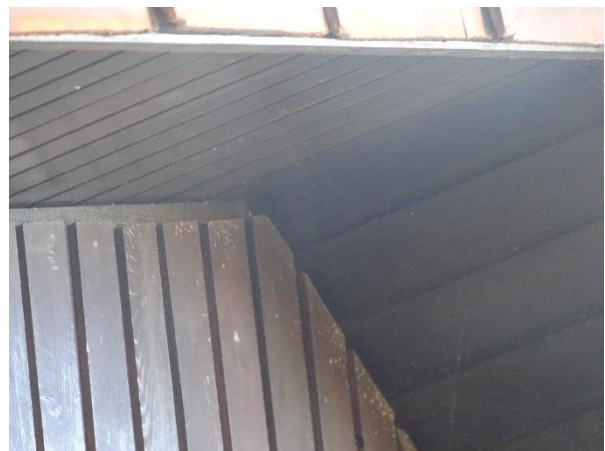
Abb. 18: Oberer Giebelbereich an der Nordseite ohne Einflugmöglichkeiten
