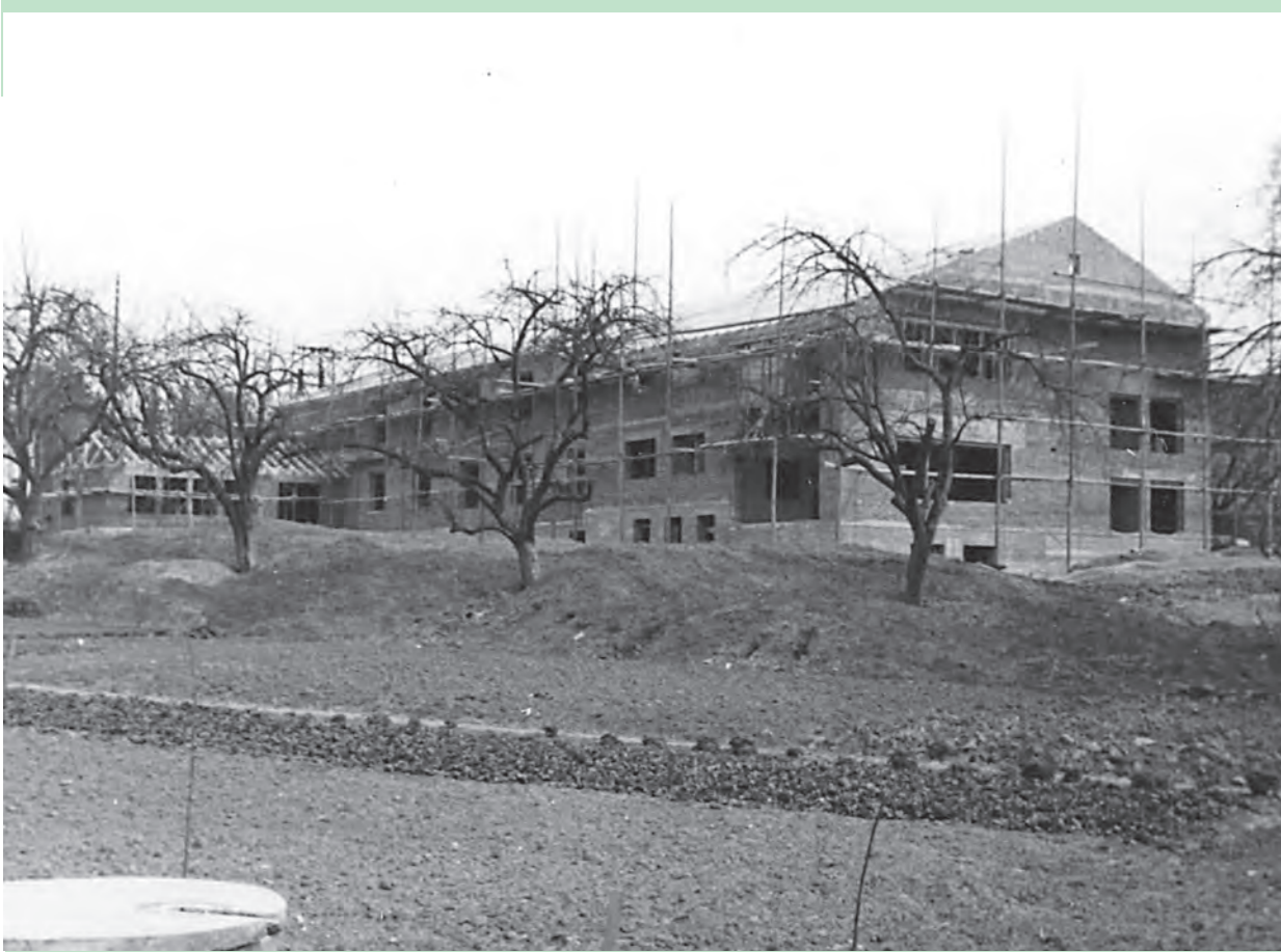
Hier der Rohbau an der noch unbefestigten Ringstraße.
